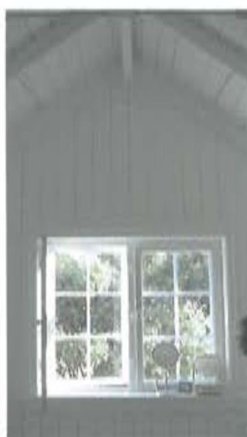
Ombygning, eget hus, 2002, Holte HAVEANLÆG
