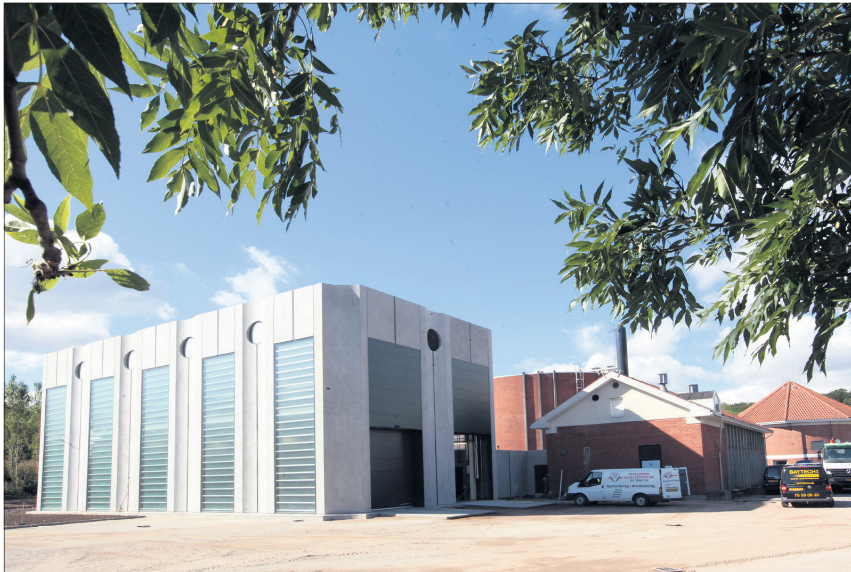
Vejle Spildevand har valgt at den nye slamhal skal være både funktionel og til at holde ud at se på. Stilen er forskellig fra den ældre del af anlægget med de røde mure, men læner sig til gengæld op ad den moderne stålport og poppelskulpturen ved Toldbodvej - udformet af Ingvar Cronhammar.
